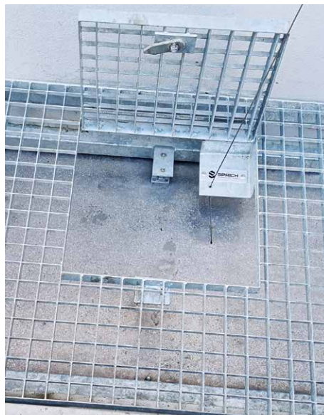
Liegende Rauchklappe: Durch Öffnen der kleinen Klappe wird der Griff am Zugseil behändigt. Damit wird dann die Blechabdeckung in die Horizontale geklappt.
