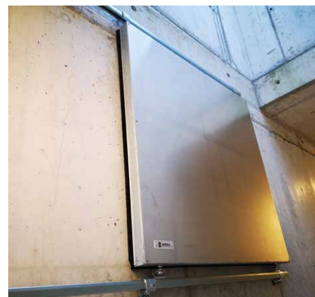
Die stehende Rauchklappe in geschlossener Position. Umlaufende, zusätzliche Bürstendichtungen gewähren die geforderte Rauchdichtheit.
